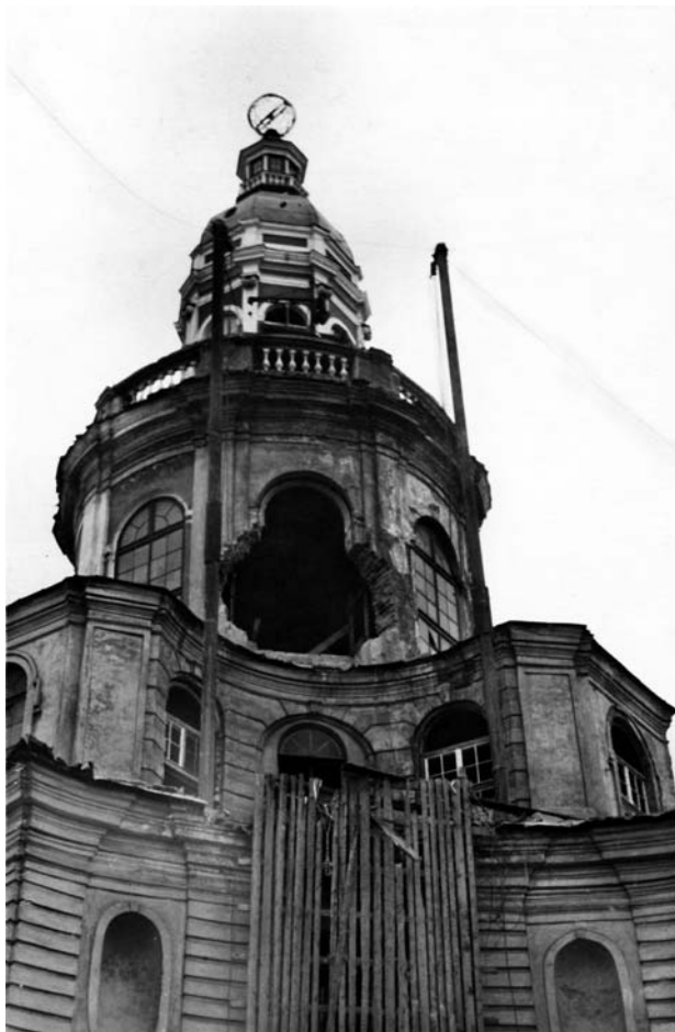
Илл. 2. Реконструкция башни здания Кунсткамеры с проемом для размещения Большого академического (Готторпского) глобуса. Ленинград. Фотография второй половины 1940-х годов. © МАЭ РАН
